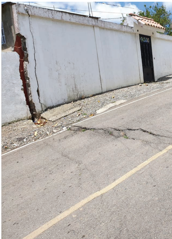
Grietas con desplazamiento lateral y vertical de la carretera de Los Amaceyes a Carlos Díaz. Foto mayo 2021.
